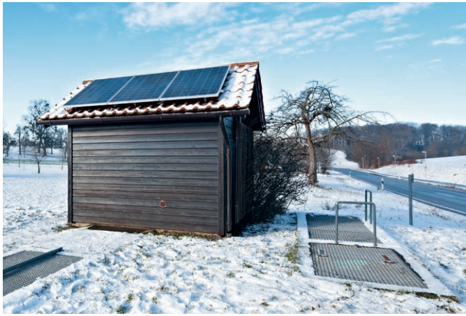
Esslingen'deki yağmur suyu depolama tankının kontrol sisteminde güneş panelleriyle elektrik sağlanıyor.
