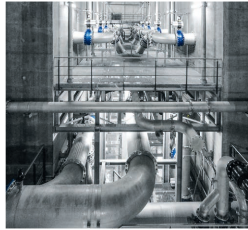
Tabandaki boruların görünümü: Festo teknolojisiyle dolu.
