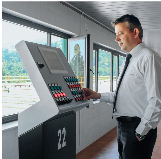
Orhan Ayhan, empleado de Festo Prozessautomation Türkei, comprueba la nueva consola de control con la que se controlan las pilas filtrantes independientemente (de forma manual o automática).
