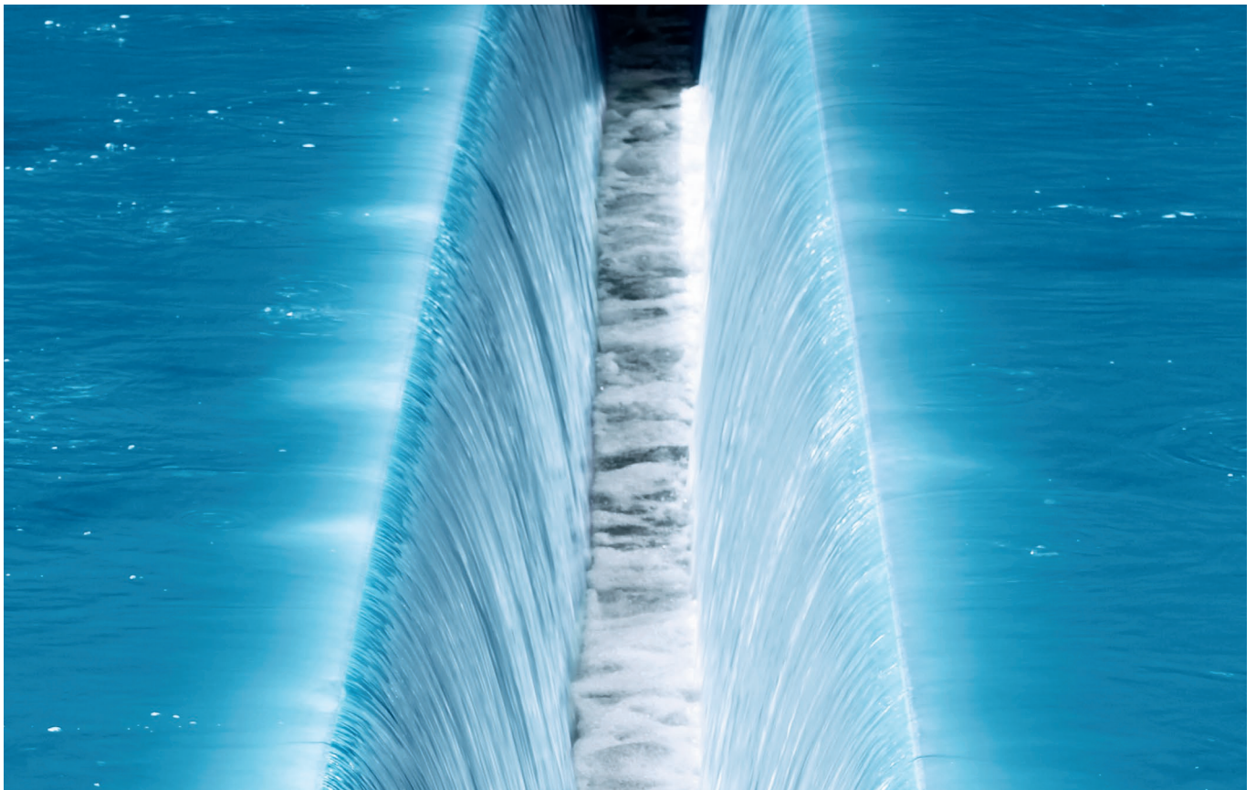
Zwei der insgesamt 28 neu automatisierten Filterbecken in Dobruca
