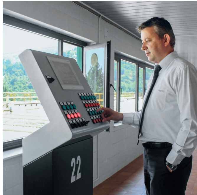
Orhan Ayhan, Festo Prozessautomation Türkei, überprüft die neuen Bedienpanel, mit denen sich jedes Filterbecken autark (manuell oder automatisch) steuern lässt
