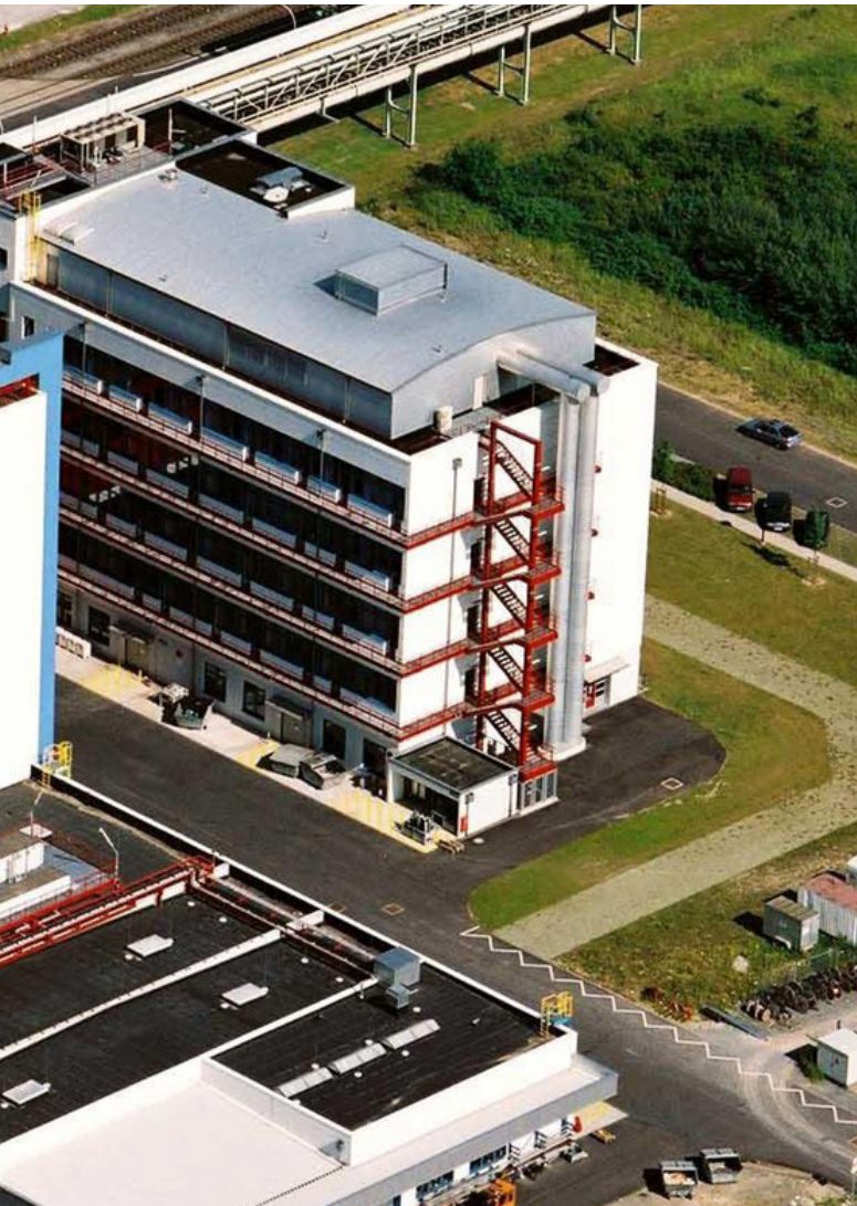
Der Vielzweck-Betrieb von Bayer Division Crop Science am Standort Dormagen, der 2002 neu errichtet wurde
