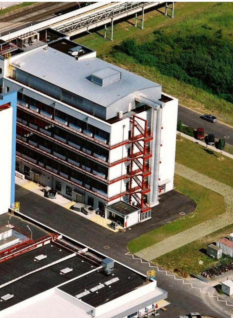
La planta multifunción de la división Crop Science de Bayer de las instalaciones de Dormagen construida en 2002
