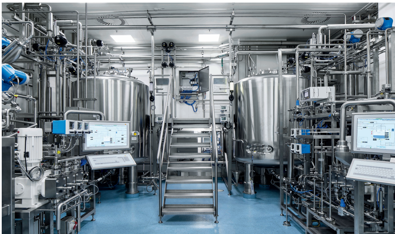
Reparaciones simplificadas. Los armarios de maniobras de Festo fueron definidos como equipos estándar desde un principio.
