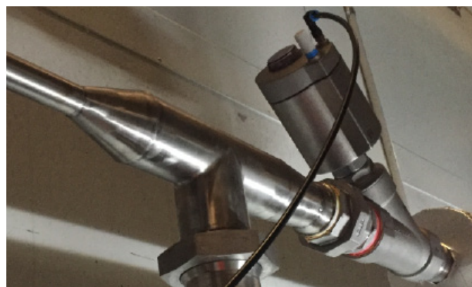
Commande d'arrêt pour le glycol utilisé dans la roduction alimentaire
