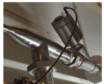
Commande d'arrêt de glycol utilisé dans la production alimentaire
