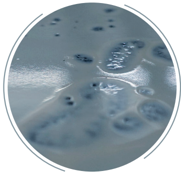
Defecto en la pintura provocado por sustancias que afectan al proceso de pintura
