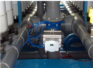
Diseñado para controlar válvulas de proceso como, por ejemplo, una válvula de mariposa
