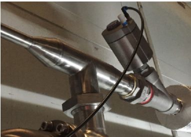
Control de cierre para el glicol utilizado en la producción de alimentos
